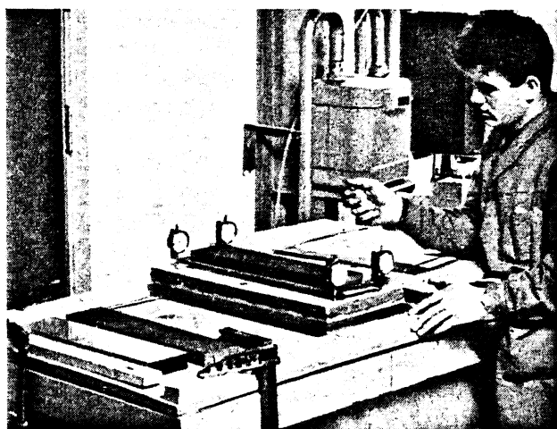
Fig. 6. Måling av luftgjennomgang i tettelist.
