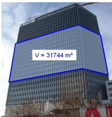
Bild 4: BlowerDoor-Messung im markierten Gebäudeteil eines Hochhauses
