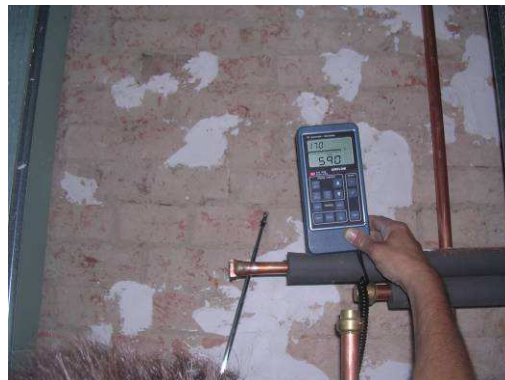
Abb. 5: Bei einer vorangegangenen Ortsbegehung wurde vorgeschlagen, das unverputzte Mauerwerk zu verputzen, doch es wurde nur punktuell nachgearbeitet. An vielen Stellen zieht es immer noch aus den offenen Fugen.
