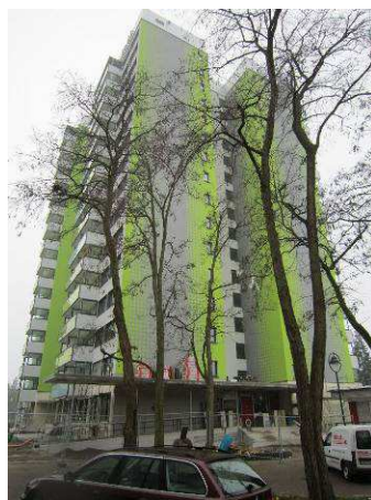
Abb. 19: Welthöchstes in Passivhausbauweise saniertes Hochhaus. Der Zielwert für den Luftdichtheitstest ist n_{50} \leq 0,45 \text{ h}^{-1} , erreicht wurden n_{50} = 0,21 \text{ h}^{-1} (Quelle: Passivhaustagung Innsbruck 2011). Rechts in der Zeichnung die Anordnung der Referenzdruckmessstellen. Grün die Differenzdrücke zwischen innen und außen, rot innerhalb des Gebäudes, um während der Messung die Druckverluste infolge der Nachströmung beurteilen zu können.
