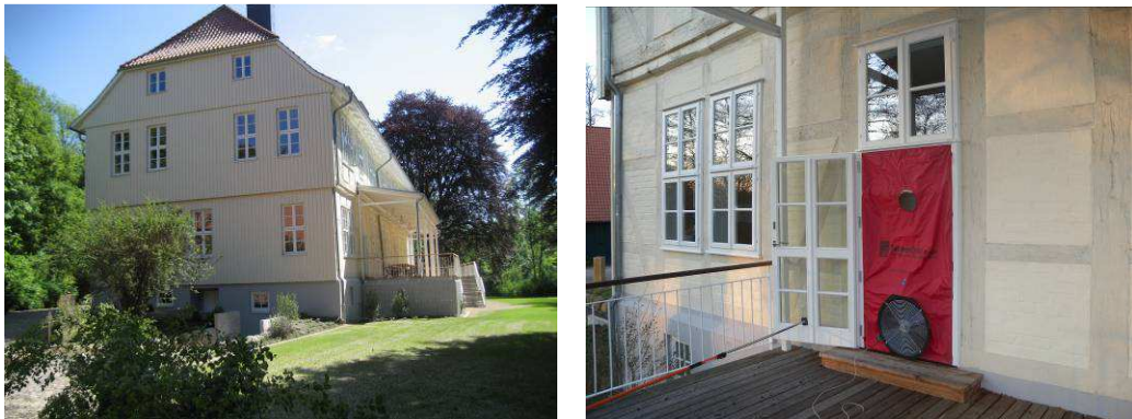
Abb. 18: Fachwerkgebäude 2008 bis 2010 saniert.
