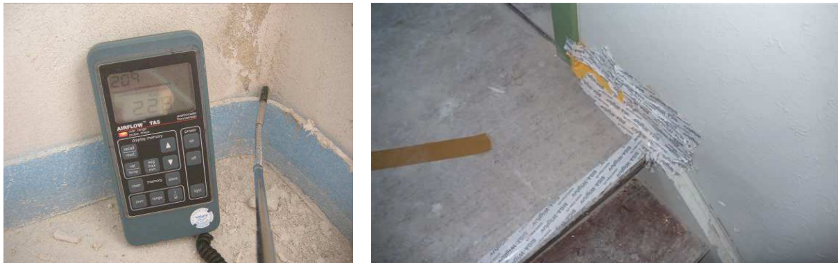
Abb. 15: BlowerDoor Test nach der Sanierung. Links: Estrichrand der Betonkappen- decke über dem Keller. Bei einer Luftdichtheitsmessung vor der Sanierung wäre aufgefallen, dass die Decke luftdurchlässig ist und es hätten Maßnah- men zur Dichtung vor dem Aufbringen des Estrichs getroffen werden können. Rechts: Oberes Treppenpodest. Durch die Abschottung des Podestes zum unbeheizten Dachboden wäre diese Leckage zu beheben gewesen.
