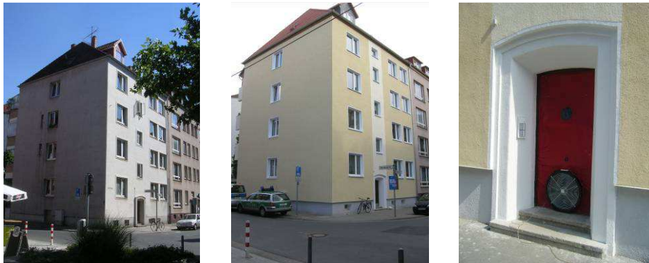
Abb. 16: Mehrfamilienhaus vor und nach der Sanierung. Das BlowerDoor Messsystem wurde in die Haustür eingesetzt.
