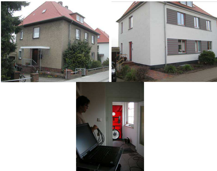
Abb. 14: Vor und nach der Sanierung
