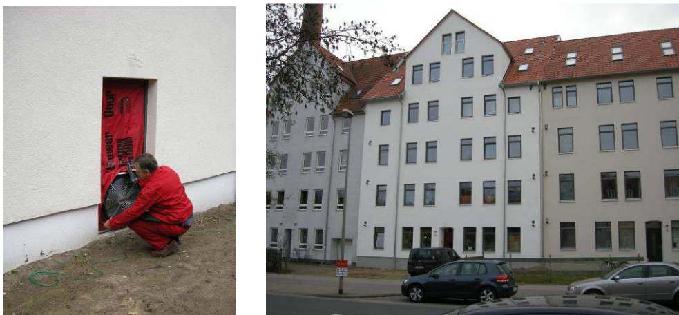
Abb. 1: Einbau des BlowerDoor Systems in einem sanierten Mehrfamilienhaus
